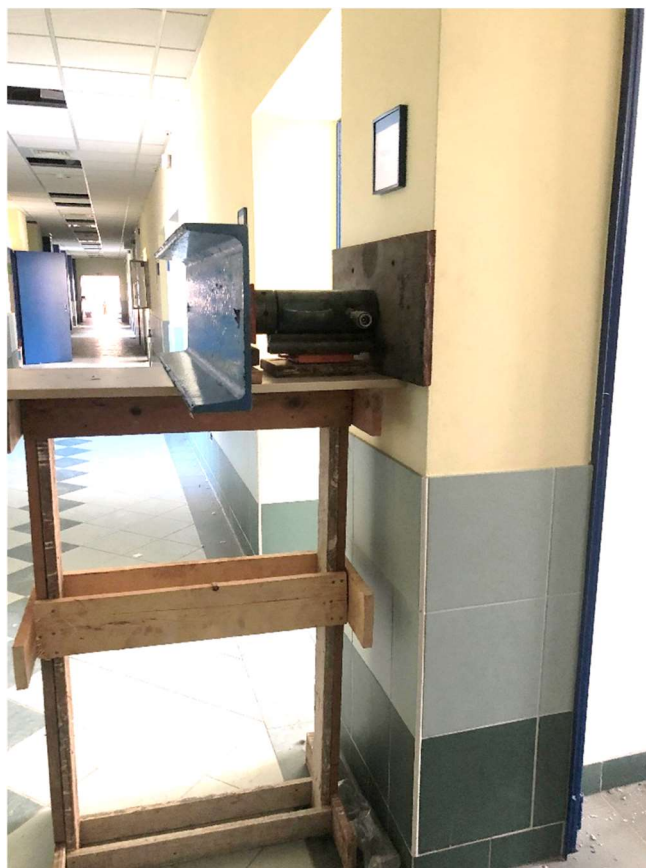
Fig.10. Profilo UPN e martinetto, posti nel corridoio.
